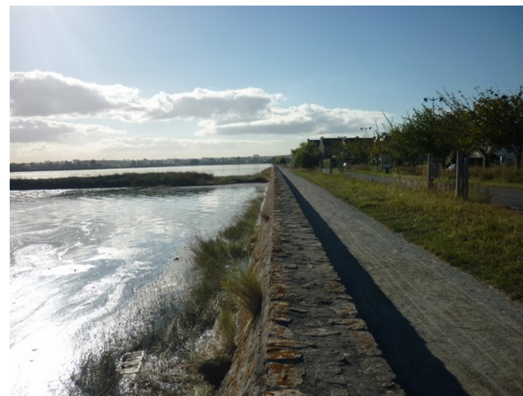
Digue des grèves de Languieux (source : DDTM 22/SRSB/RN)
