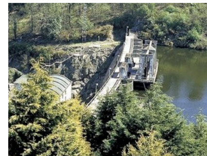
Barrage Pont Rolland – Hillion
