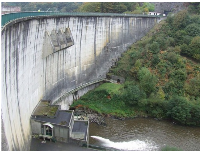
Barrage du Gouët – La Méaugon
