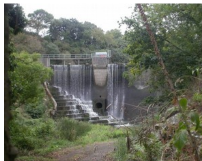
Barrage de Rophémel – Plouasne
